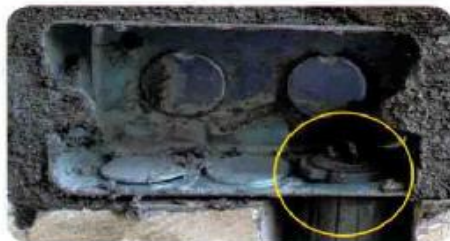
▲ 施工期间，可用孔盖塞住管孔，以免杂物跑进配电管中。出线盒后方也要用水泥封好固定。
