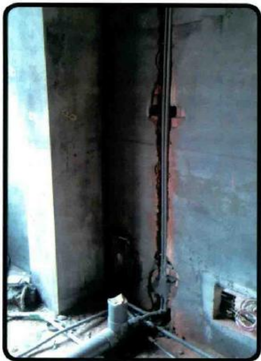
▲ 在马桶排粪管后方多加个排气管，就可以防止与邻近马桶“互动”的困扰。
