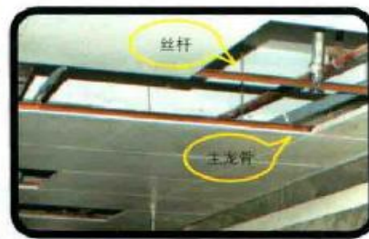
▲轻钢龙骨结构，主龙骨调平要准，不然吊顶会不平。
