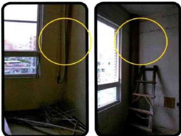
▲ 管线可用木假梁包裹起来，日后才好维修。
