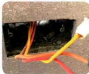
▲ 线盒常易有泥土块跑进去，易刮伤电伤绝缘层。最好还是拿报纸或纸板封住盒口。
