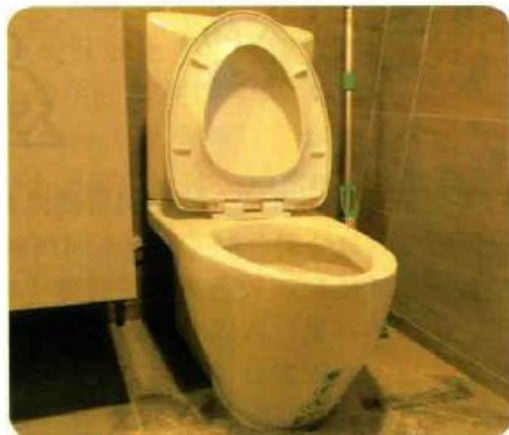
▲ 鸡肉卷家的马桶，后来他自己加了一段管子，改变排粪管的出口位置，总算把新马桶装了上去。
