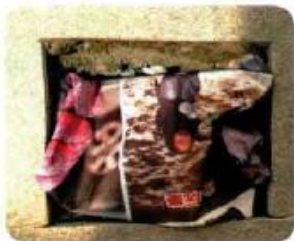
▲ 线盒常易有泥土块跑进去，易刮伤电伤绝缘层。最好还是拿报纸或纸板封住盒口。
