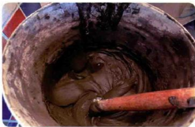
▲ 湿铺施工底层用的水泥浆。
