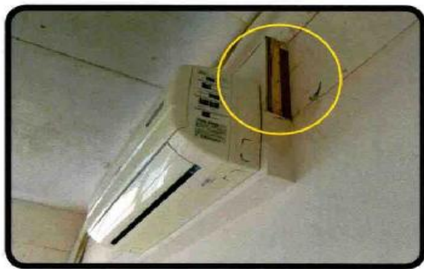
▲ 若是轻钢墙，在空调吊挂后方要加18mm厚的多层板。
