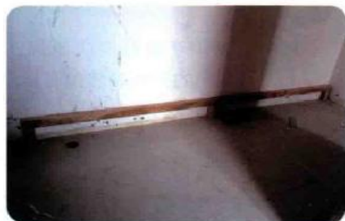
▲▼ 柜子留脚，可防底下湿气，也可调整不平的地板。固定柜在做之前（下图），会先以龙骨做出柜脚高度。
