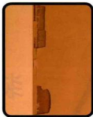
▲ 漆面在木墙衔接处很容易裂开。记得先上粘胶，并将木板表面打磨，可增加油漆的附着力。
