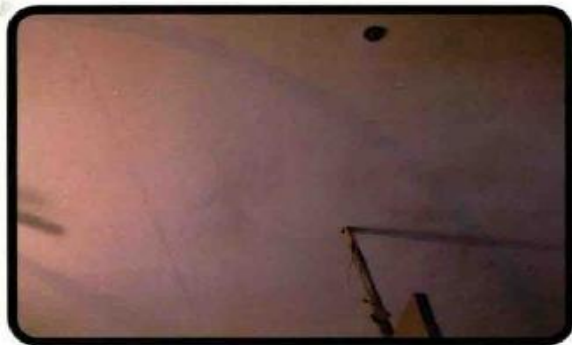
▲ 刮腻子两次的天花板顶棚，表面就平整多了。
