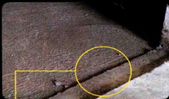
▲ 防水浆料做止水墩 在门槛的地方，可用防水浆料做高一点的平台来当门槛底下的止水墩，可阻挡水向外渗。
