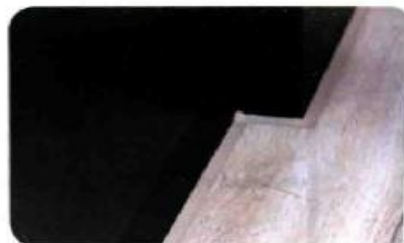
▲ 伸缩缝约8到12mm，可直接用玻璃胶收边。
