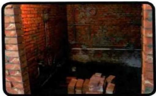
▲ 重做卫生间的隔墙，要注意承重力。
