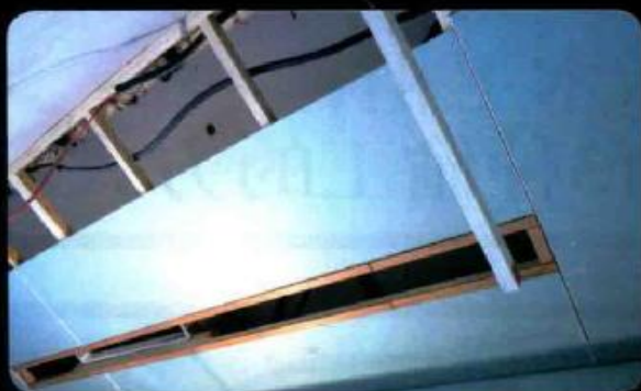
▲ 灯具或空调出口要再加四周固定龙骨。 图片提供_环球石膏板
