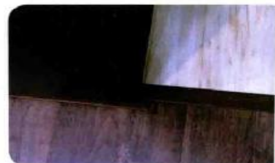
▲ 伸缩缝约8到12mm，可直接用玻璃胶收边。
