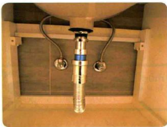
▲ 水槽下水管装好后，三角阀处（黄圈处）还在滴滴答答。
