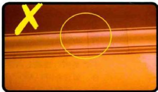
▲ 房子验收时，线条板不但可看到多处衔接，还可看到钉枪痕迹，这应是木工完工后，刮腻子没做好就上漆的结果。
