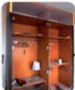
Step2 柜门拆除，保留柜身
