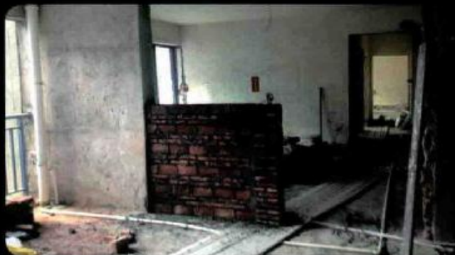
⚠ 砖墙不能一次完工 砖墙一天最高就是砌 1.5 米，不能一天就从地板砌到天花板，下方砖体会歪掉。图片提供：AYDESIGN
