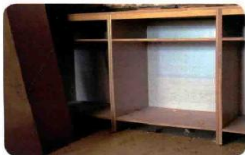
▲▼ 柜子留脚，可防底下湿气，也可调整不平的地板。固定柜在做之前（下图），会先以龙骨做出柜脚高度。
