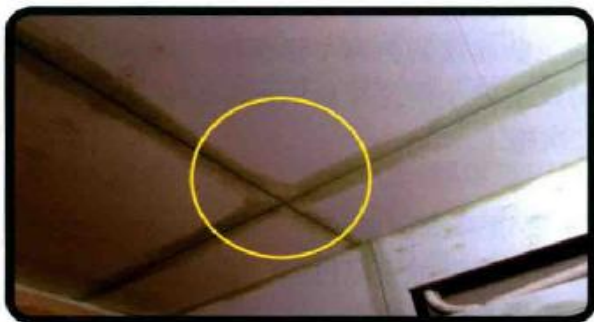
▶ 天花板吊顶刮腻子前，要先用粘胶粘合缝隙（图中绿色部分就是上了粘胶），之后再封防裂胶带。
