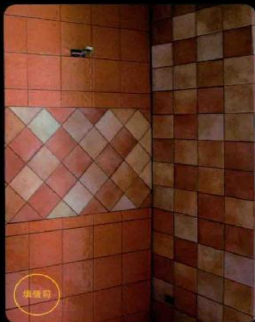
▲▶ 墙面砖填缝美感加分 与尚未填缝的墙面相比，填缝后，瓷砖片片分明，两者的外观差别很大吧！图片提供_集集设计
