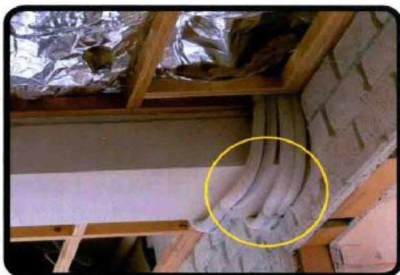
▲ 空调管线要少弯折（左图），弯折若较多（右图），则要小心不要把冷媒铜管压折到。
