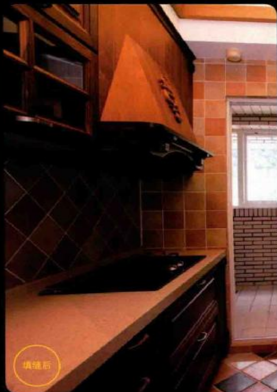
▲▶ 墙面砖填缝美感加分 与尚未填缝的墙面相比，填缝后，瓷砖片片分明，两者的外观差别很大吧！图片提供_集集设计
