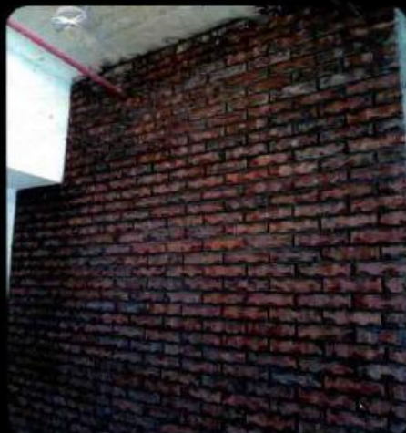
⚠ 砖墙不能一次完工 砖墙一天最高就是砌 1.5 米，不能一天就从地板砌到天花板，下方砖体会歪掉。图片提供：AYDESIGN
