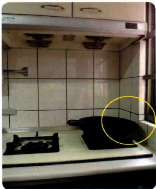
▲ 燃气灶右侧太靠近墙，用炒菜锅时会容易撞到墙。
